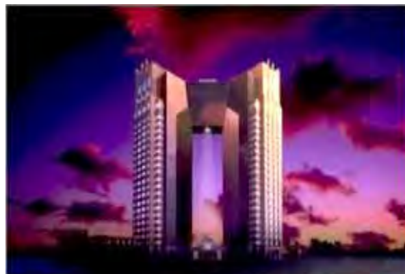
東京ベイコート倶楽部 (建設中)
